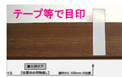
◆物差しを<縦枠と上枠>の2面に当てながら ⇒ 物差しの100mm位置に合わせて、上枠にテープ等で目印を付ける ⇒ 物差しを外す
