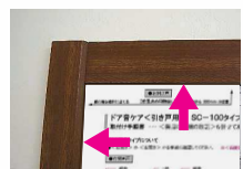
◆物差しを<縦枠と上枠>の2面に当てながら ⇒ 物差しの100mm位置に合わせて、上枠にテープ等で目印を付ける ⇒ 物差しを外す
