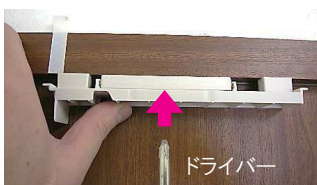
◆工具の穴にドライバーを挿入 ⇒ そのままドライバーで少し押込めば、工具からベースが外れて上枠に<仮固定>されます。
